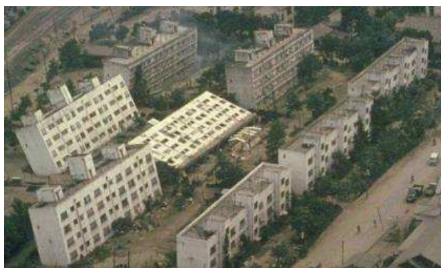
Effetto dei terremoti su edifici che sorgono su suolo incoerente.
